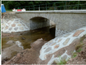
Pont sur la RD 15
