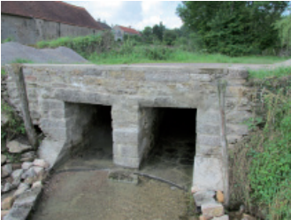
Pont sur la RD 15D
